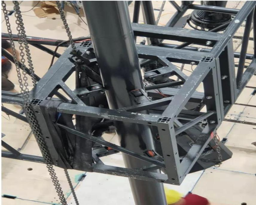
如现场查看 TRUSS 架和支撑柱仍有较大距离时，应采用金属挂接、钢丝绳加 U 卡扣固定连接，如下图所示：
